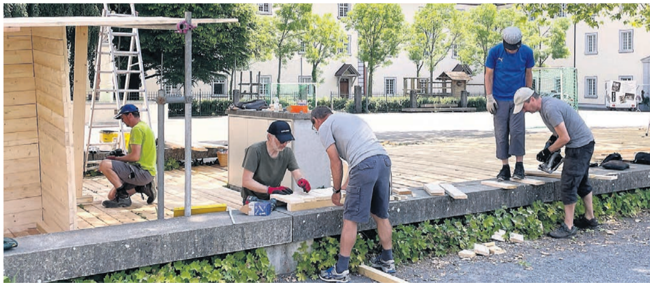
Intensiv wurde letzte Woche auf dem Klosterhof gearbeitet, bis Tribüne und Bühne fertiggestellt waren.
